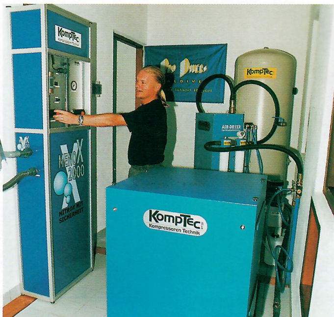
Eine der modernsten Nitrox-Membran-Anlagen befindet sich auf der lauschigen Malediven-Insel Kuredu. Hier checkt Basenbetreiber Steffan Hansson die Werte
