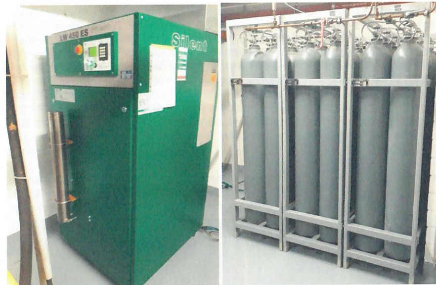
Abb. 6.4 und 6.5 Hochdruck-System mit dem Hochdruck-Kompressor links und den Hochdruckflaschen rechts.
