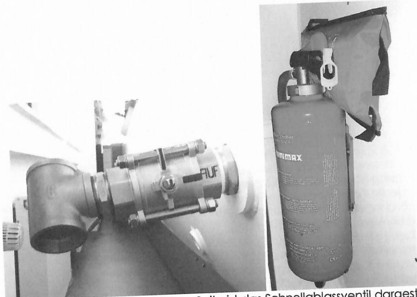
Abb. 6.11 und 6.12 Auf der linken Seite ist das Schnellablassventil dargestellt und rechts ein drucktauglicher Feuerlöscher mit Wasser als Löschmittel sowie einer zusätzlichen Löschdecke.
