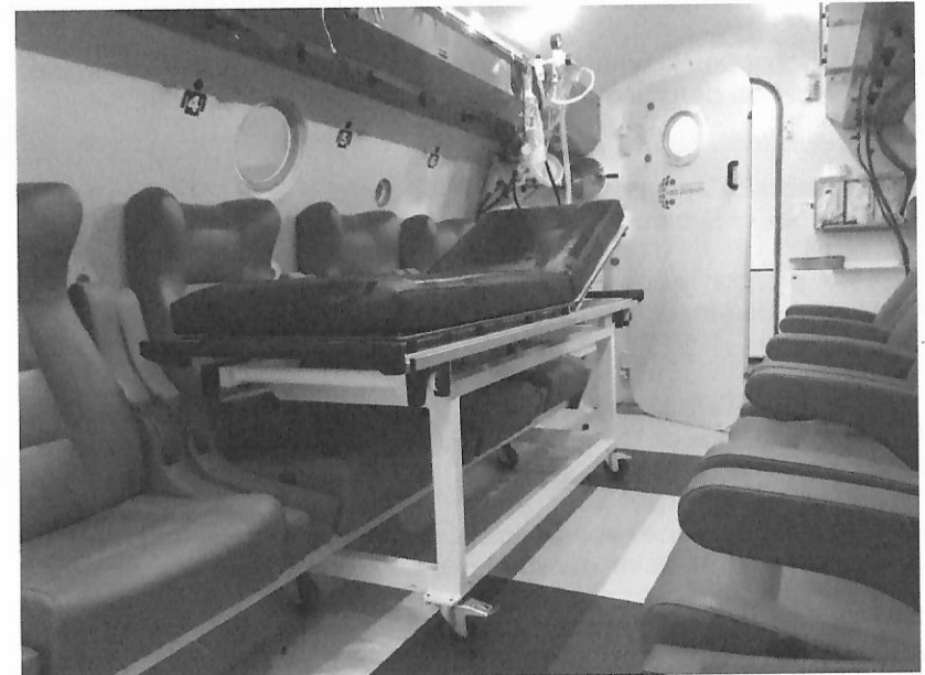
Abb. 5.3 Mehrpersonendruckkammer des HBO-Zentrums Euregio Aachen mit einer Trage zur Behandlung von liegenden oder beatmeten Patienten
