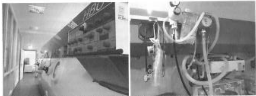
Abb. 9.3 und 9.4 Beatmungsgerät des HBO-Zentrums Euregio Aachen, auf dem linken Bild ist der elektrische Teil des Servo Ventilator 900 C außerhalb der Kammer und auf dem rechten der pneumatische Teil innerhalb der Druckkammer zu sehen.
