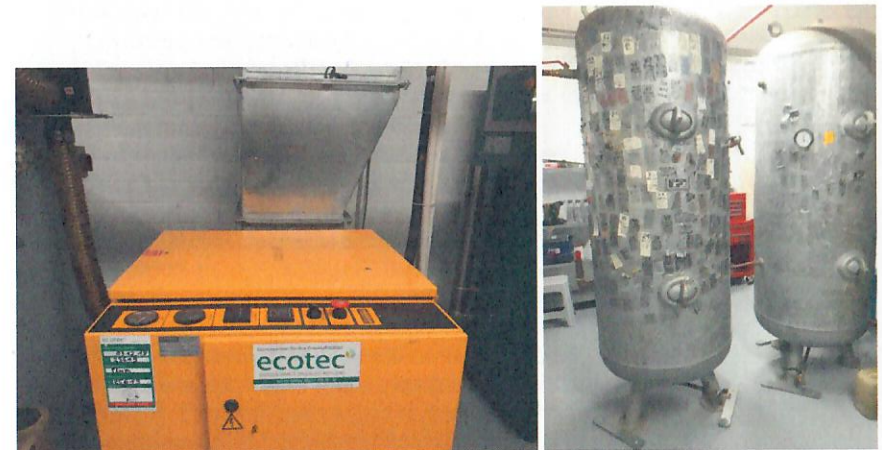
Abb. 6.6 und 6.7 Niederdruck-System mit Niederdruckkompressor links und Niederdruck-Vorrat rechts.
