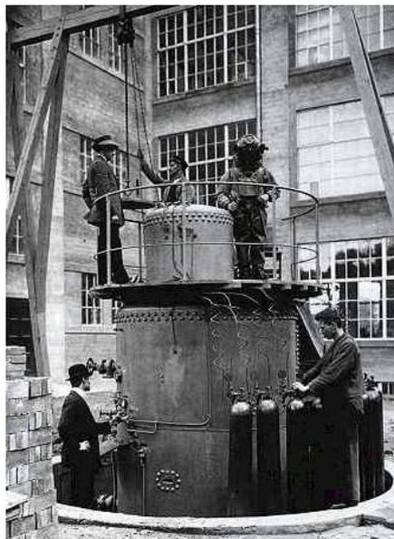
Für Versuchs- & Forschungszwecke gab es bereits Anfang des 20. Jahrhunderts bei der Fa. DRÄGER in Lübeck einen Tauchturm. Am 17. Juli 1914 wurde erstmalig ein Taucherteam dem Druck von ca. 9 Bar (80 m) für 40 min. ausgesetzt.
